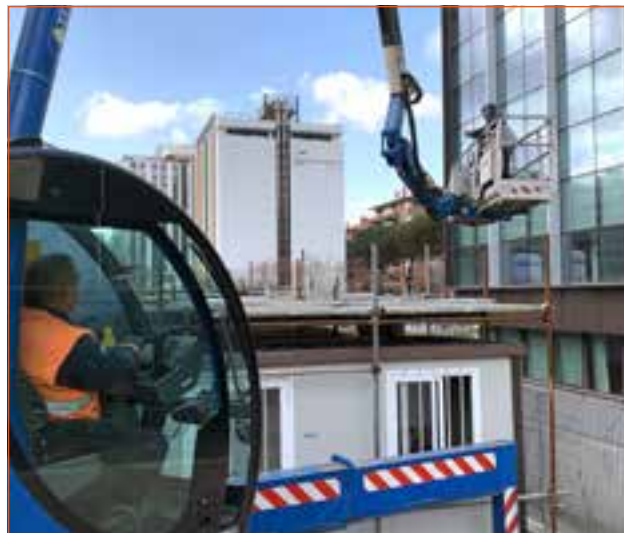
Utilizzo di piattaforma aerea autocarrante articolata.
